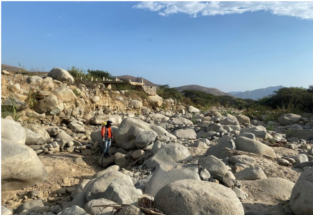
FIGURA N° 03: EN LA TEMPORADA DE MAXIMAS AVENIDAS, EL RÍO SINSICAP, SE DESBORDA EN ESTE TRAMO DEL SECTOR PUENTE VIEJO, ARRASANDO CON TODO LO QUE ENCUENTRA A SU PASO, ACA SE VE LA EROSION DE LA VIA ADYACENTE.
